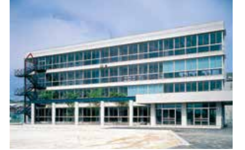
今治明德高等学校 矢田分校校舎竣工
