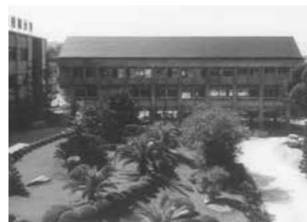
特別教棟建設
